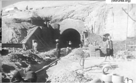
Construction d'un laboratoire souterrain
