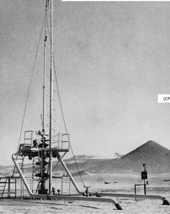
Puits d'injection de gaz sous pression, afin d'augmenter la production de pétrole
