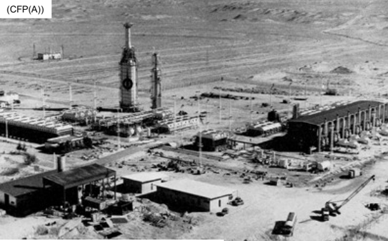
Le complexe industriel d'Hassi-Messaoud
